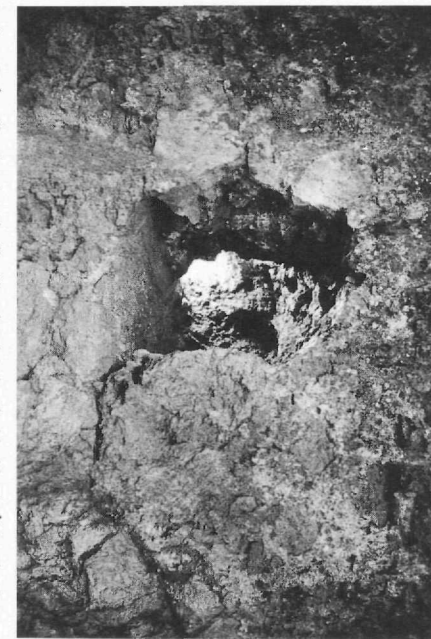
Abb. 2: Bis heute sind in der 1997 wieder freigelegten Uhrturmkasematte die Minenkammern erhalten geblieben.
