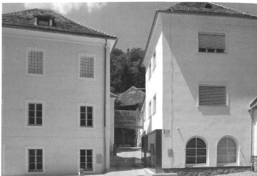
Abb. 7: Durch Öffnung des Museumsareals und farblich ein- heitliche Gestaltung erhält der Gebäudekomplex spürbare Präsenz im Stadtraum. Foto: LMJ, Nicolas Lackner
