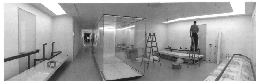
Abb. 6: Durch die Ausstel- lungsarchitektur aufgelockerte Gang- Raumsituation: Hier in einer Panoramaansicht während der Umbauphase. Foto: LMJ, Nicolas Lackner
