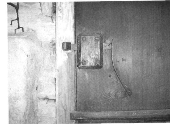
Abb. 17: „Schubriegel in Holzkasten mit Holzfeder“<sup>26</sup> (Türsperre aus Holz) in der „Kainhütte“ (Foto: F. Mandl)
