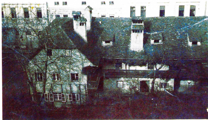
Abb. 4: Hofansicht des Hauses Schörgelgasse Nr. 8, PAM
