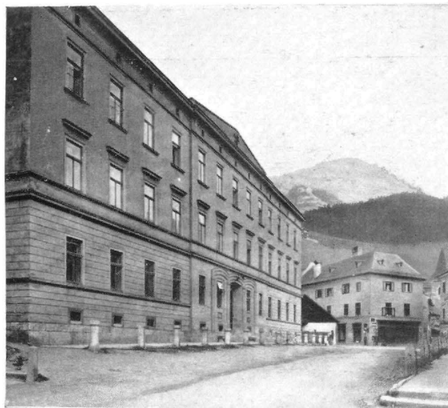
Abb. 41. Amtshaus der Österr.-Alpinen Montangesellschaft, erbaut 1865.
