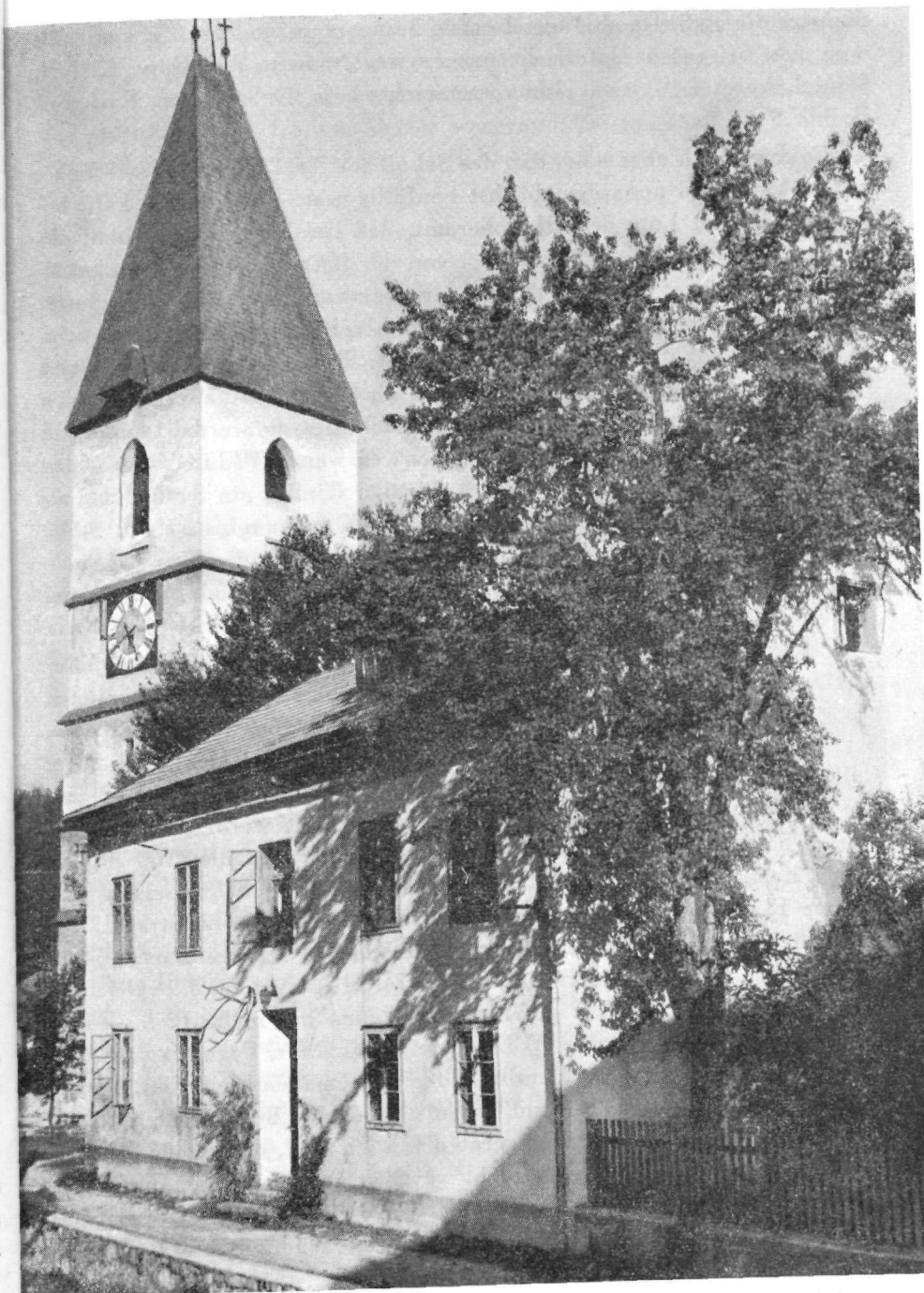
Abb. 1. Altes Schulhaus in Bad Aussee.
