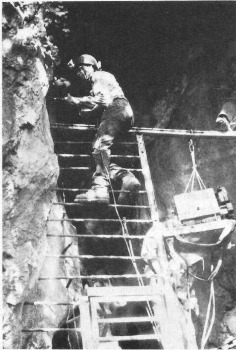
Abb. 2: Anbringung des Schutzgitters bei der Steinbockhöhle
