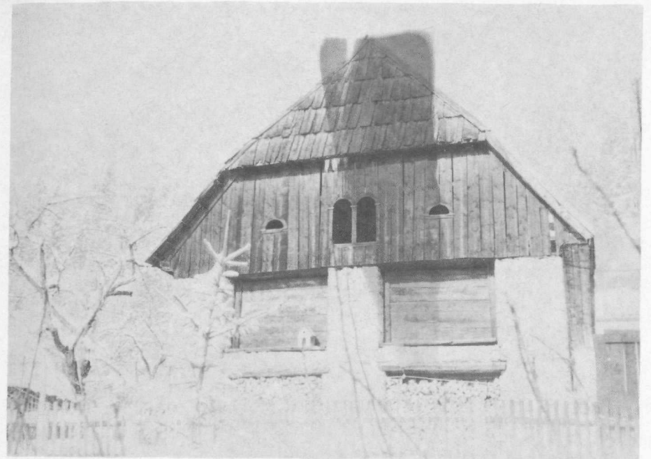
Abb. 5 Die für das ganze Gebiet typische Dachform (45 Grad steiles Schopfwalmdach und verbrettertes Giebfeld) mit Giebelluken als Doppelbogenfenster. Stadel des alten Schulhauses, Schöder Nr. 3.
