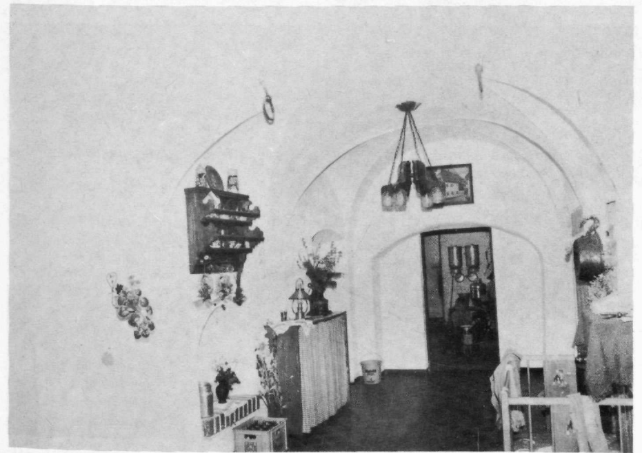
Abb. 3 Stichkappengewölbe im Flur des Erdgeschoßes mit Eisenringen als Schlachtvorrichtung beim vulgo Ligg, Baierdorf Nr. 37.
