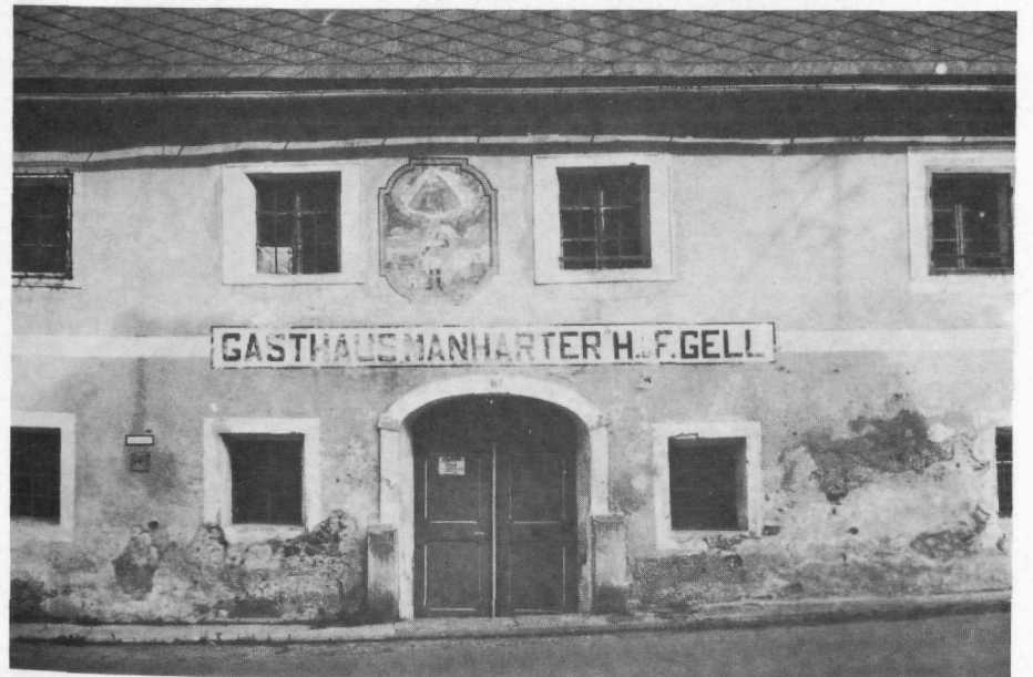
Abb. 7 Zweiflügelige Tür mit Oberlichte am Gasthaus Mainharter, Baierdorf Nr. 2, das mit zum ältesten Hausbestand des Ortes gehört – urk. 1393 erwähnt, in seiner heutigen Form 1724 errichtet.
