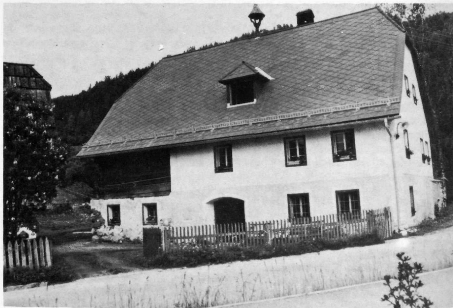
Abb. 1 Wohnhaus in Mischbauweise beim vulgo Kaspriedl, Schöder Nr. 35. Das steile Schopfwalmdach hat heute Eternitdeckung und trägt einen eigentlich im benachbarten Lungau heimischen Glockenturm.
