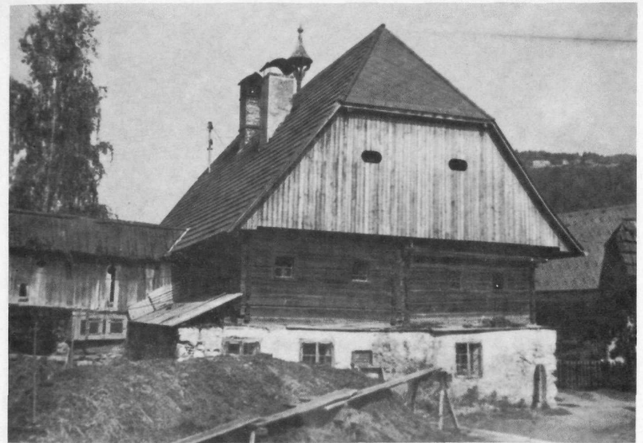
Abb. 2 Ansicht der westlichen Giebelfront des vulgo Kaspriedl, Schöder Nr. 35, mit dem hölzernen Verbindungsgang zur Scheune.
