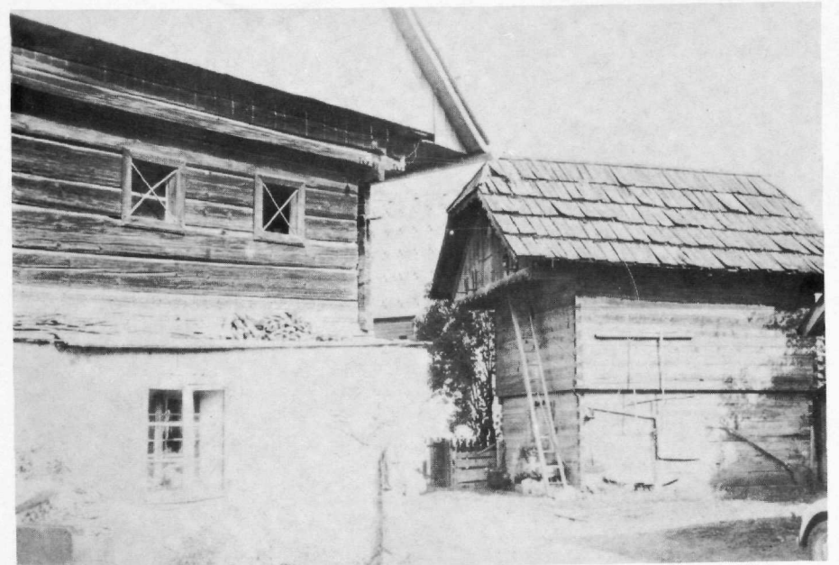
Abb. 9 2-geschoßiger Getreidekasten beim vulgo Kaspriedl, Schöder Nr. 35 mit Klingschrotzimmerung und Datierung (1740) am Deckentram des Untergeschoßes.
