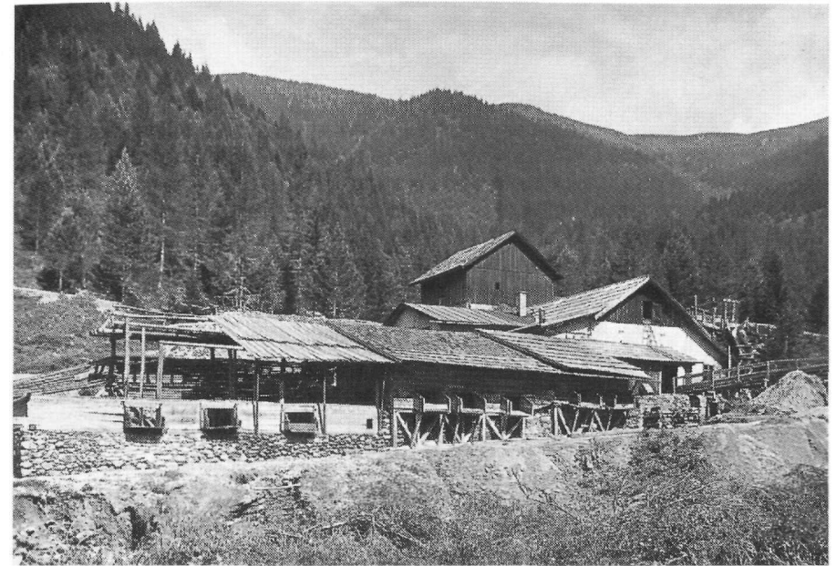
Abb. 5: Aufbereitungsgebäude (rechts) und Erzverladeanlagen (links) beim Bergbau in der Walchen, um 1923/24. Undatierte Fotografie im Besitz der Firma Zellulose- und Papierfabriken Brigl & Bergmeister AG, Niklasdorf.
