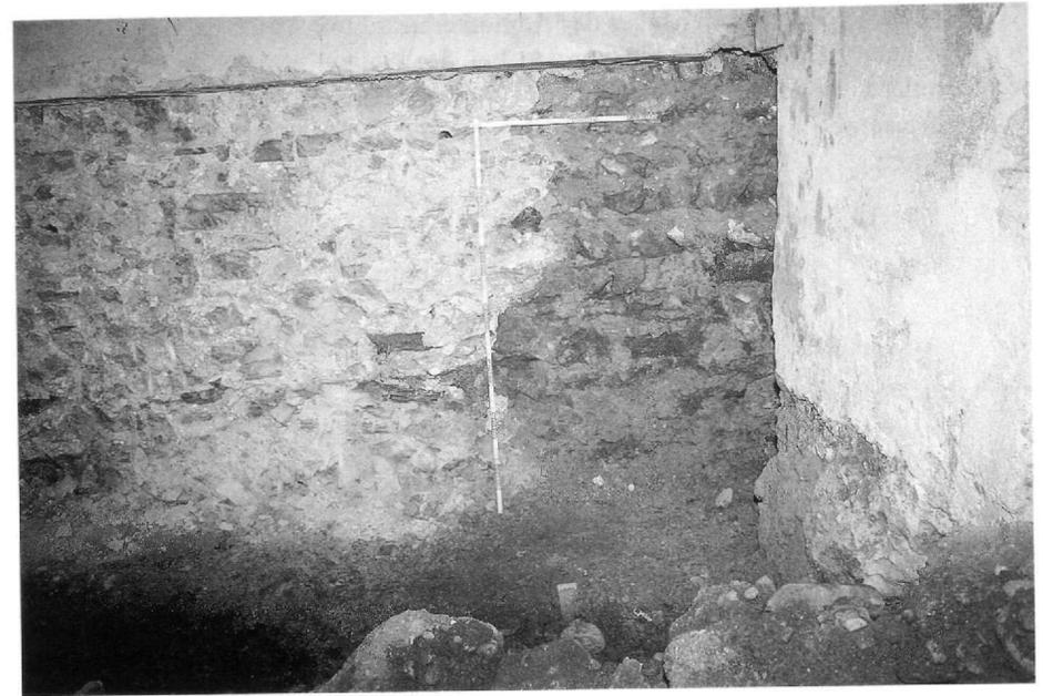
Abb. 7: Baunaht zwischen mittelalterlichem und neuzeitlichem Mauerwerk im Aufgehenden der Stadtmauer
