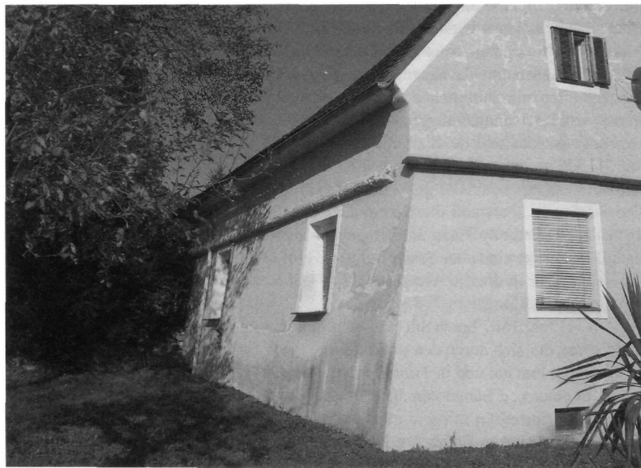
Abb. 3: Pfarrgasse Nr. 9 mit den an der westlichen Fassade sichtbaren Bruststeinen
